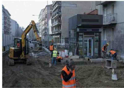
Imprese Operai al lavoro in un cantiere (LaPresse)
